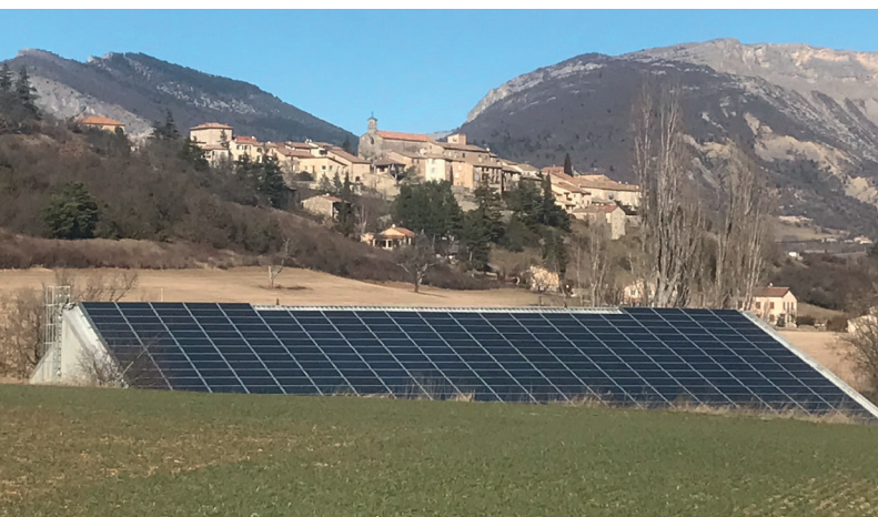
Toit de panneaux photovoltaïque à Lagrand _Cittànova
