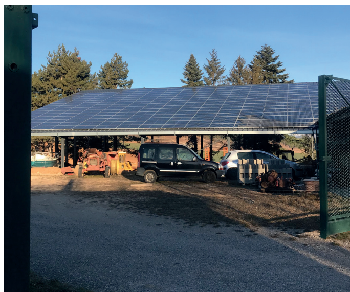
Toit de panneaux photovoltaïques sur hangar agricole à Mison _Cittànova
