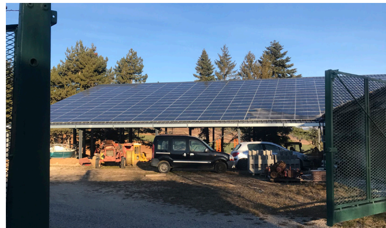
Toit de panneaux photovoltaïques sur hangar agricole à Mison _Cittànova
