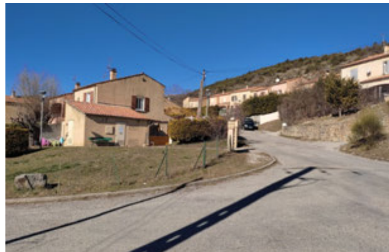
Lotissement au nord du bourg de Rosans, hors enveloppe et architecture endémiques
