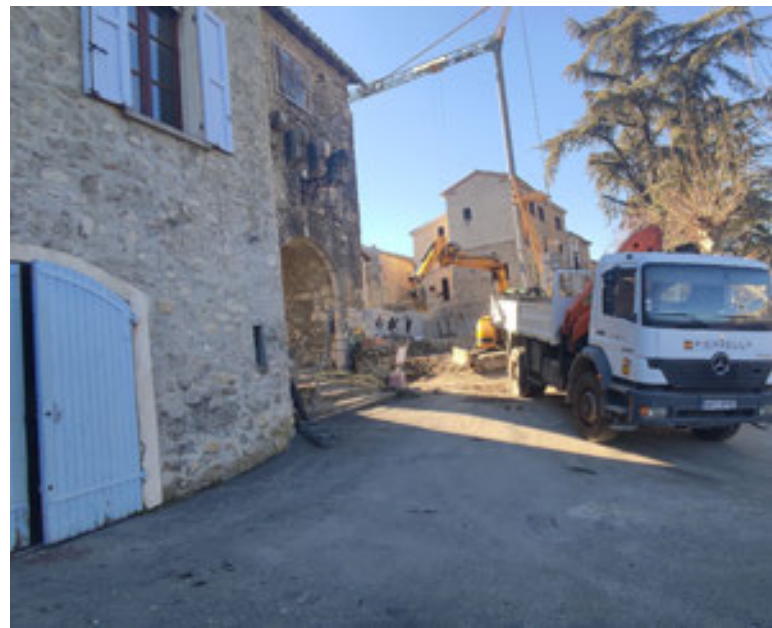
Travaux de rénovation, Ventavon_Cittànova
